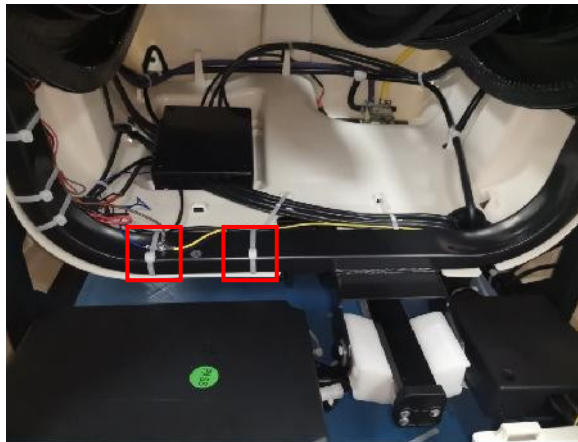
A.cut cable tie
